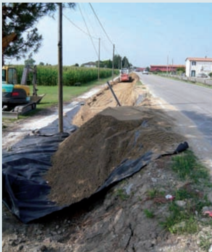
Via Pirami durante il periodo dei lavori
