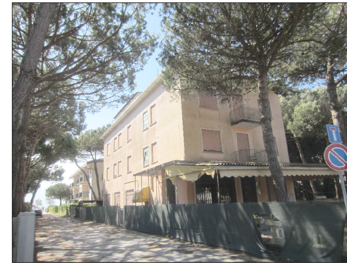
Foto 4 - Vista accesso al mare (nord)
