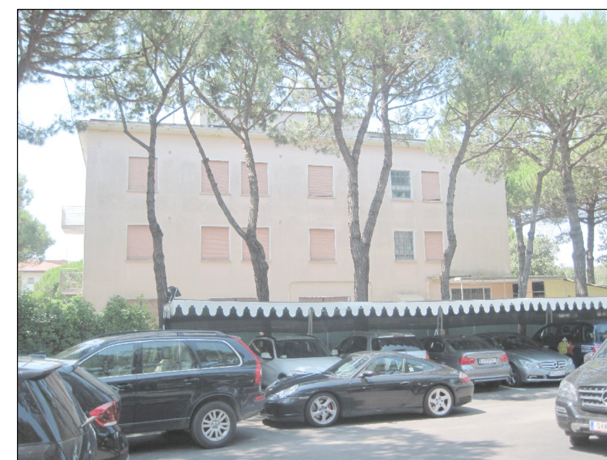
Foto 3 - Vista laterale est
