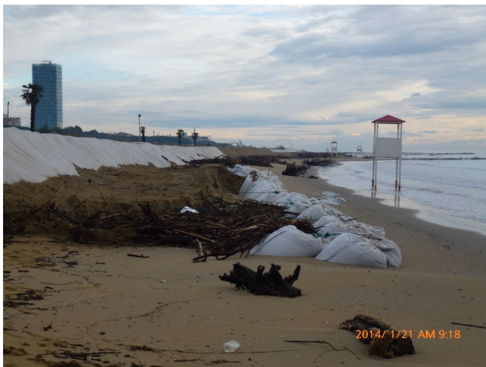
Foto 3-3 Jesolo, zona tra stab. Riviera Levante e Vill.Marzotto, spessore erosione ~60 cm
