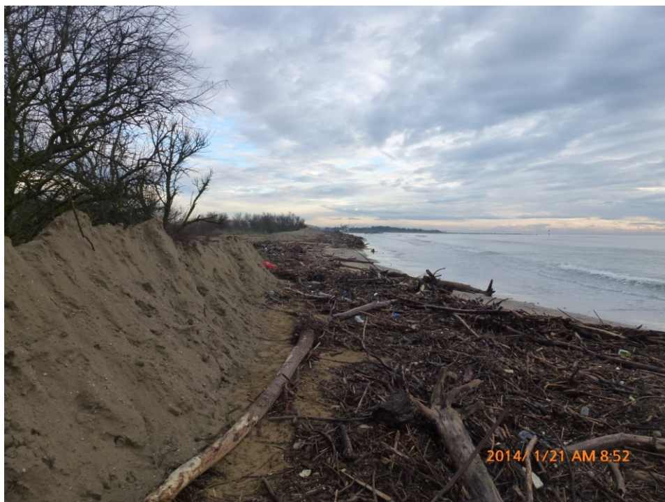
Foto 3-2 Jesolo, zona tra foce del fiume Piave e cond. Merville, spessore erosione ~2,50ml
