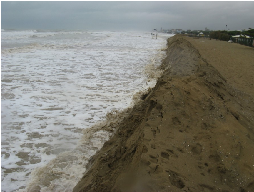
Foto 2-5 Jesolo, fronte Malibù, durante la mareggiata del 19 novembre 2013
