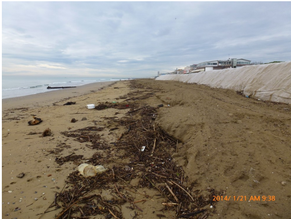
Foto 3-4 Jesolo, zona tra stab. Riviera Levante e Vill.Marzotto, spessore erosione ~60 cm
