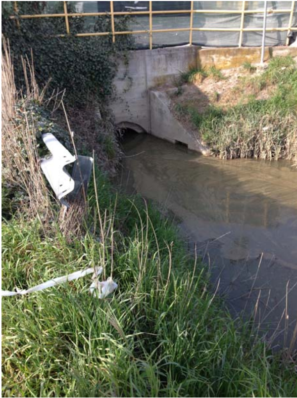
Manufatto di imbocco DN 1400 mm
