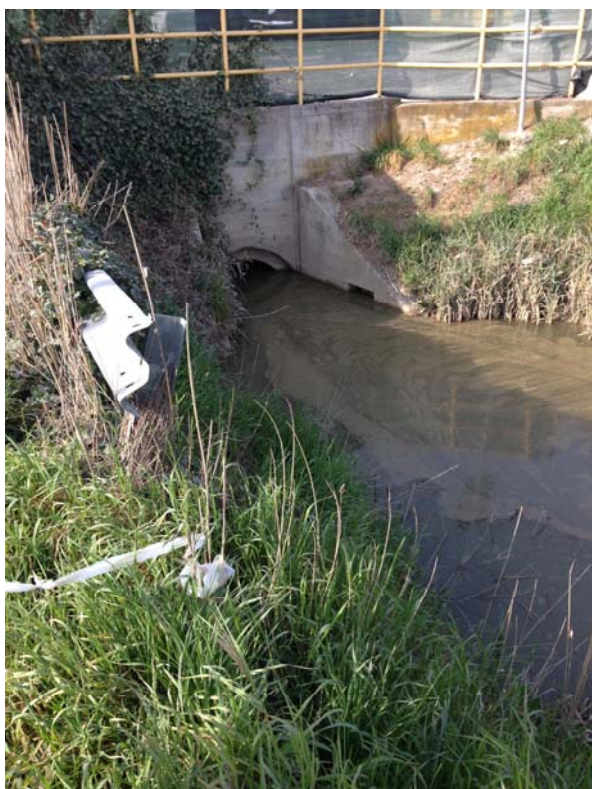
Manufatto di imbocco DN 1400 mm
