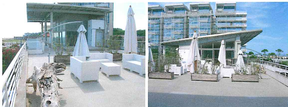
Solarium 1 Piano. con spazio commerciale a sx. e ristorante a dx
