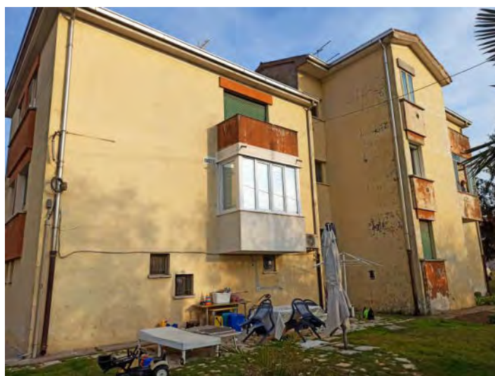
Vista edificio da nord-ovest
