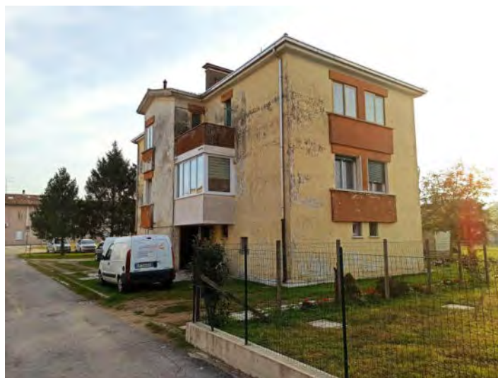
Vista edificio da nord-est
