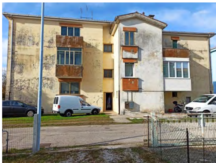
Vista edificio da est
