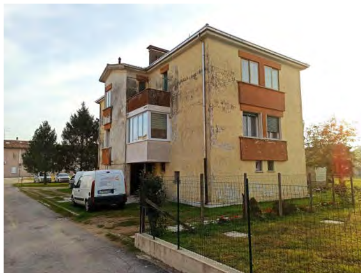
Vista edificio da nord-est
