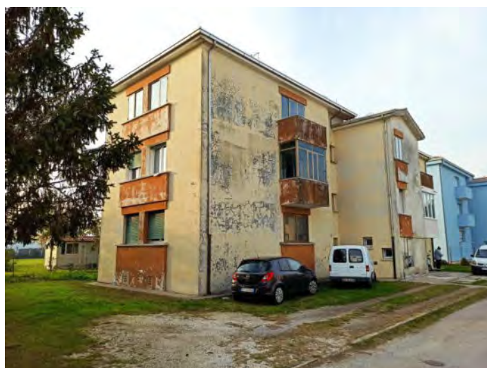
Vista edificio da sud-est
