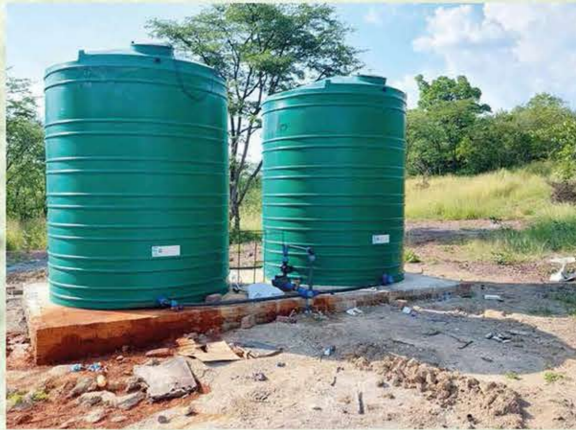
Il nuovo pozzo
